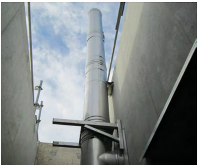
ECIB dimensionne, fabrique et installe les pièges à sons permettant l'évacuation des calories du local.
